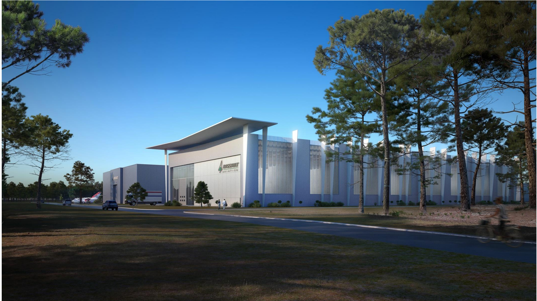
Figure 6 : Aperçu du projet depuis l'entrée du site Dassault Aviation (source Dassault Aviation).
